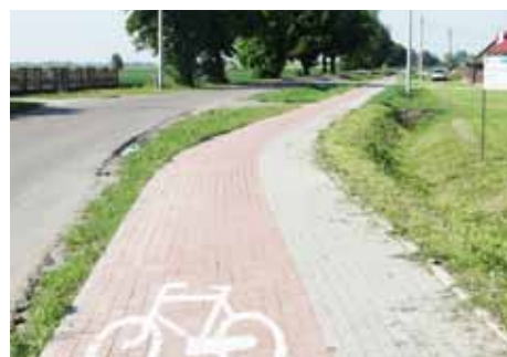
Ścieżka pieszo-rowerowa w miejscowości Tragamin
