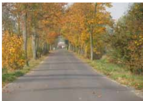
Remont drogi gminnej w Stogach
